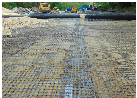
Fig. 4b: Rolling out Abgrid geogrid
