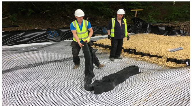
Fig. 3: Uncoiling Erosaweb TRP
