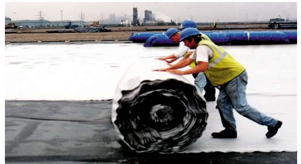
Fig. 5: Pozidrain rolling out
