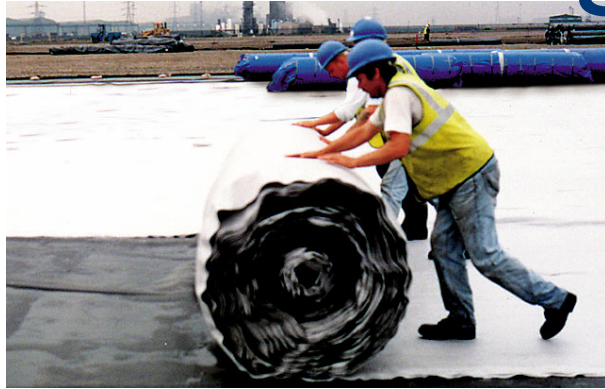
Fig. 5: Pozidrain rolling out
