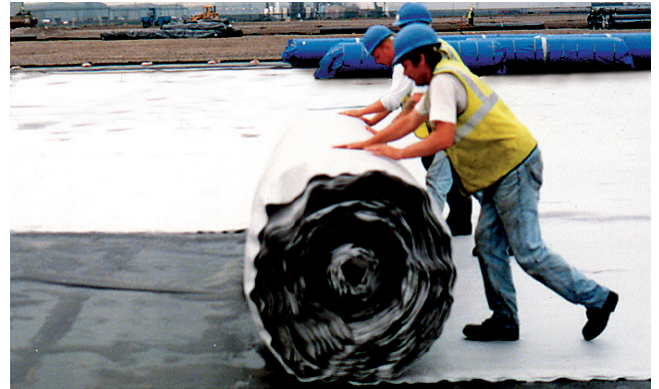
Fig. 5: Pozidrain rolling out
