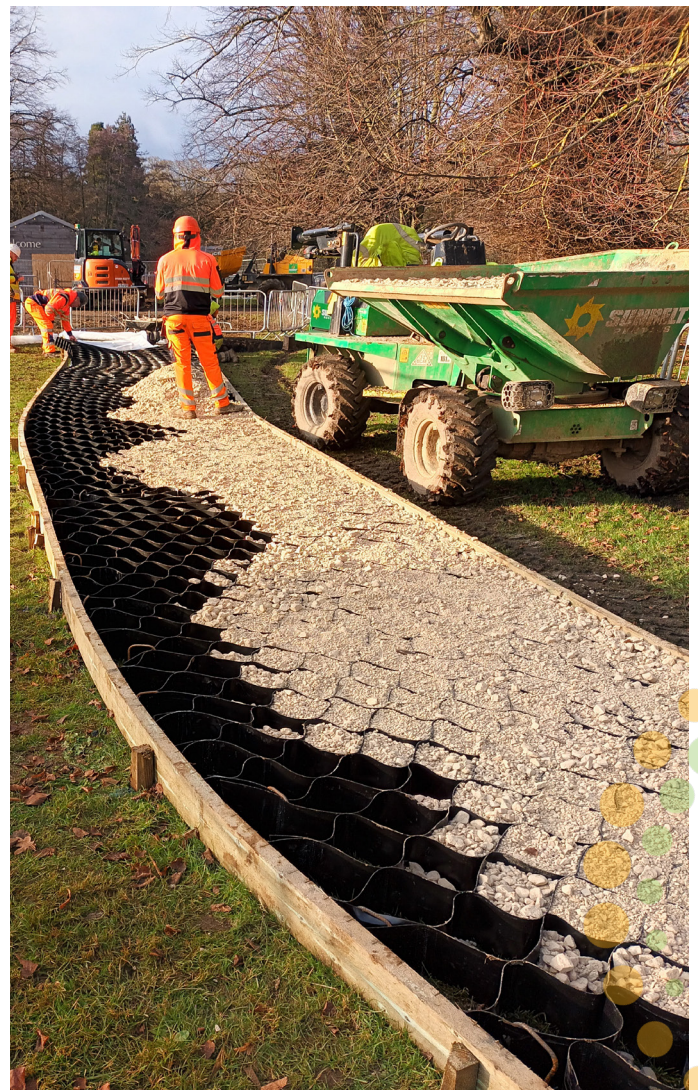
ABG Abweb TRP panel installation
